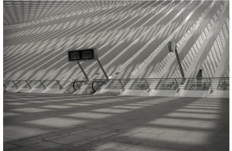
Gare des Guillemins, Liège (B), 2009
